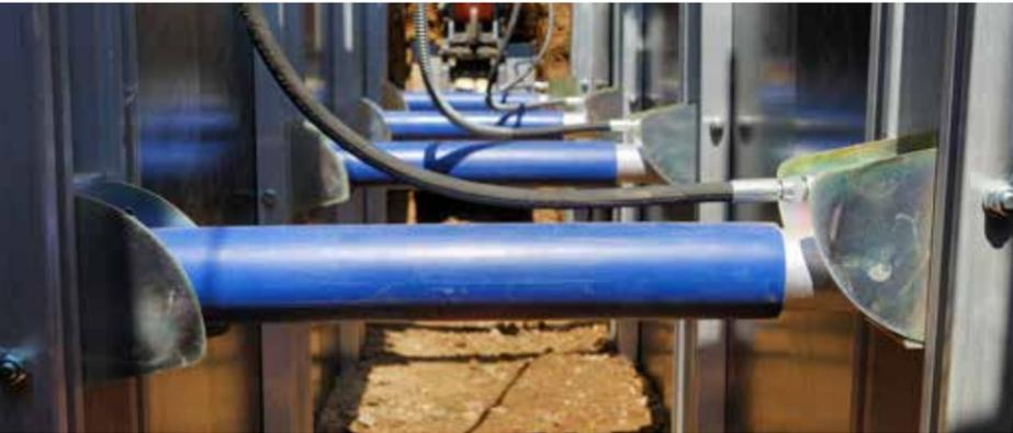
Le blindage rapide de la série 260 convient spécialement pour les profondeurs de blindage jusqu'à 2,00 m.
