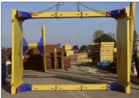
Durch weiteres Umschwenken um 90° ist die Rollenschlittenbox richtig aufgestellt. Der Kopf der Platten weist nach oben und die Box steht auf den Schneiden bzw. auf den Rungen der Aufstockplatten. Der Richtungspfeil „oben“ der Rollenschlitten mit A-Stellung weist jetzt nach oben.
